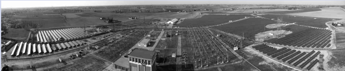
Impianto fotovoltaico di Focomorto nei pressi di Ferrara
