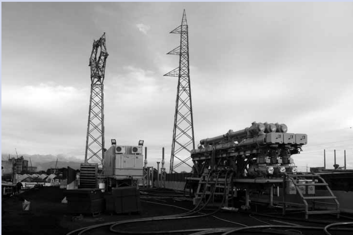
Stazione di Connessione a Rapida Installazione ad Aprilia
