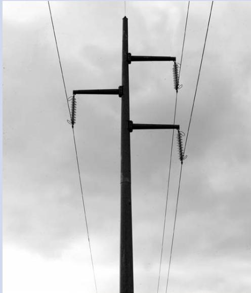
I **sostegni tubolari** rappresentano un'importante innovazione nella realizzazione delle linee a Alta e Altissima Tensione. La soluzione compatta della struttura garantisce infatti il minimo ingombro e costituisce una valida alternativa, in determinate condizioni di inserimento nel paesaggio, ai convenzionali sostegni tronco-piramidali.
