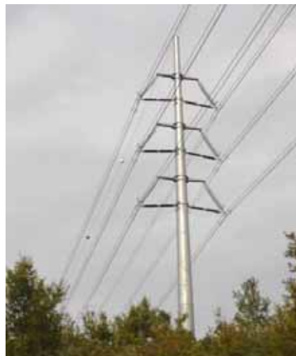
Figura 2.2 – Tipico sostegno a traliccio – singola terna (sinistra) esempio di sostegno tubolare monostelo – linea compatta (destra).
