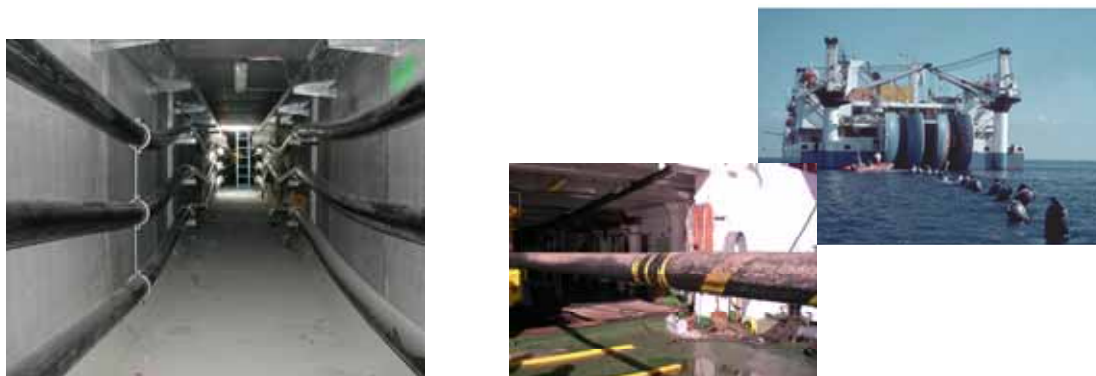
Figura 2.3 – Cavo interrato (sx): due terne 380 kv equivalenti ad una singola terna aerea. Posa in opera di un cavo sottomarino (dx): nave armata per lo stendimento e particolare del cavo durante l'operazione.
