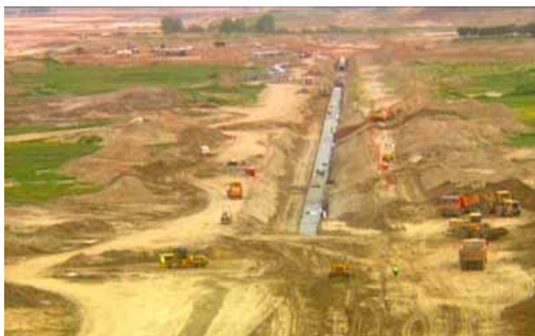
Figura 3.5 - Esempio di posa in campagna di una doppia terna di cavi 380 kV] nei pressi di un aeroporto (Spagna).
