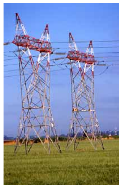
Figura 3.11 – Cassetta-nido sull'elettrodotto che affianca l'autostrada Roma-Fiumicino.
