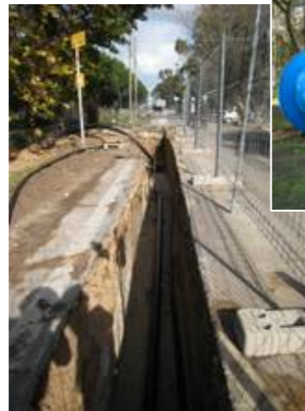
Tunnelgrabung für Verlegung
