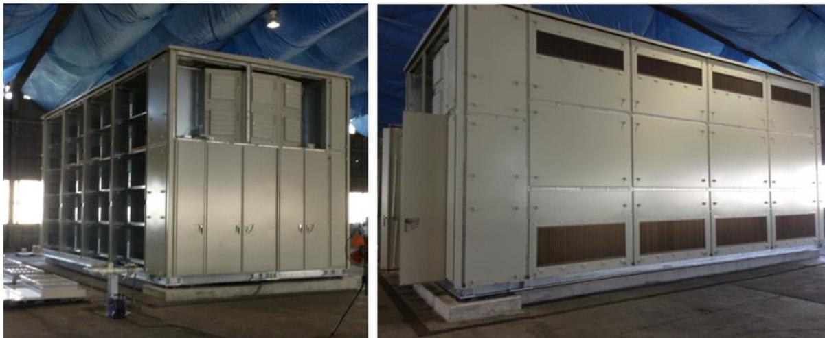
Figura 8 – Shelter dell'assemblato batterie NAS da 1,2 MW
