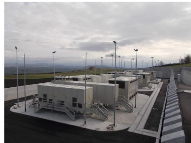
**Ciascun impianto SANC da 12 MW è caratterizzato da una energia nominale netta scaricata di 80 MWh:**
