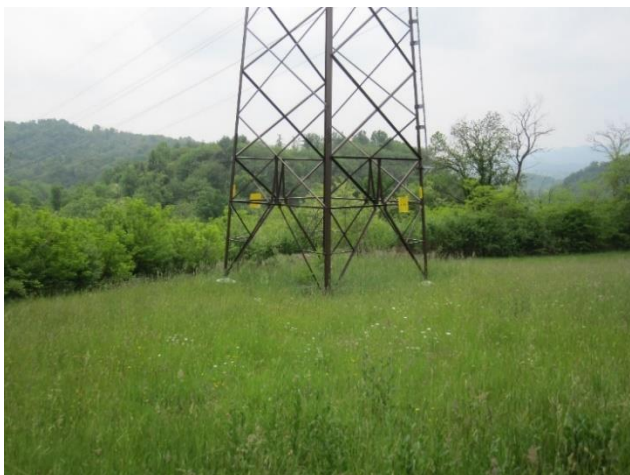
Figura 8 Intervento di inerbimento sulle linee 132 kV della Val D'Ossola Sud
