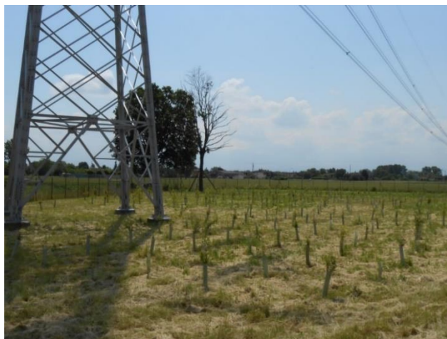
Figura 9 Intervento di messa a dimora di alberi e arbusti sulla linea 380 kV Chignolo Po - Maleo
