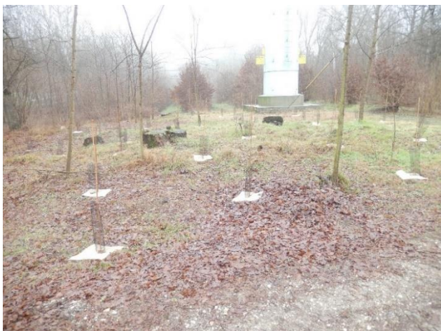
Figura 6 Interventi di ripristino nel Parco naturale della valle del Ticino sulla linea 380 kV Trino-Lacchiarella
