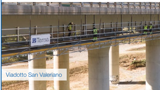
Posa dei cavi all'interno di un viadotto
