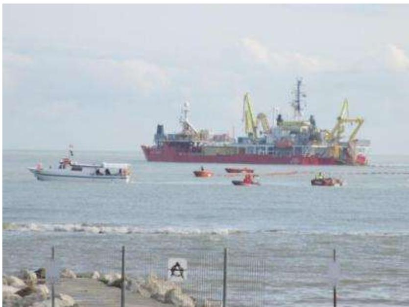
Figura 24 Esempio di posa di un cavo sottomarino in prossimità dell'approdo terrestre
